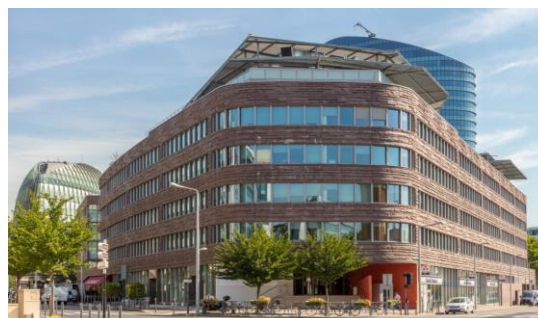
GALEO & DUEO ILM1 (92) - SCI GALEO & DUEO ILM1 gérée par Primonial REIM France
